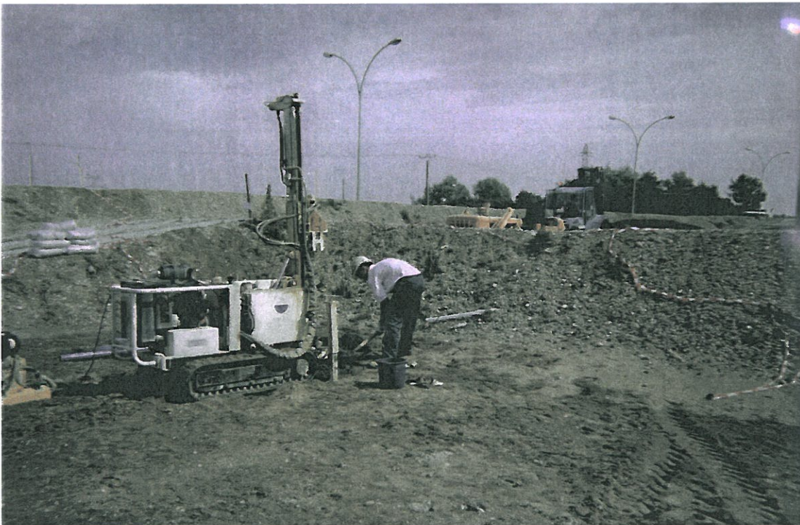
Figure n°6 : Réalisation du piézomètre PZ9.
